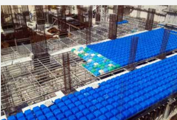
Técnica da protensão assegura a redução de custos, evita desperdício de material e aumenta a segurança do trabalhador
